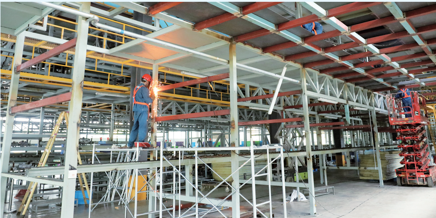
在云南弥渡产业园区区长岭片区,一家医疗器械生产企业正在加快建设车间,准备投产。(摄于8月29日)
