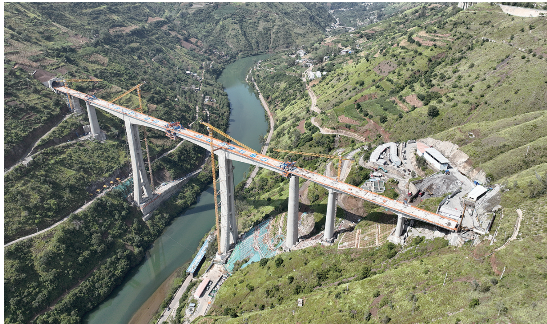
9月7日在云南省昭通市鲁甸县江底镇拍摄的渝昆高铁江底牛栏江特大桥合龙现场(无人机照片)。 9月7日,由中铁二局承建的渝昆高铁江底牛栏江特大桥实现全桥合龙。大桥的合龙标志着桥隧占比高达87.4%的渝昆高铁建设取得关键性突破,为全线按期建成通车奠定了坚实基础。
