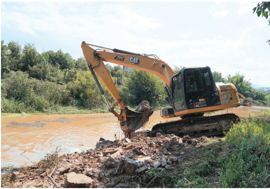
施工队在宾川县金牛镇牛井社区炼洞河段进行疏浚作业。(摄于9月7日) 强降雨过后，金牛镇牛井社区、纳溪社区却没有放松防汛这根弦，投入约12万元资金，出动5台挖掘机对辖区内约3公里白塔河和5公里炼洞河河道内的淤泥、杂草、漂浮物、垃圾及影响行洪的障碍物等进行了彻底清理，恢复河道行洪能力，为农业生产、防汛、排涝提供有力保障。
