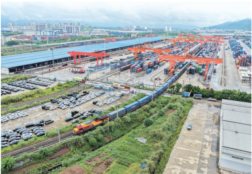
9月13日,满载汽车零部件、笔记本电脑等货物的中亚班列在重庆团结村中心站发车(无人机照片)。 据重庆铁路物流中心统计,2025年1月至8月,重庆中亚班列去程开行35列,发送箱量超3000标箱,发送货值近6亿元。 今年4月,重庆首次开行固定中亚班列,并以每月2列的固定频次实现常态化开行。相较于以往的公路转铁路的联运模式,中亚班列常态化开行后,重庆至中亚的物流时效提升20%以上,单箱成本降低15%。 〔新华社记者唐奕 摄〕
