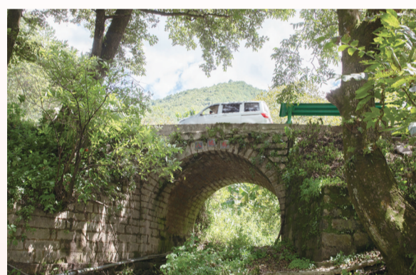
9月4日,来往的车辆正驶过八达桥。滇缅公路漾濞段是滇缅公路保留桥梁最多的路段。63公里的滇缅公路上,有各种形式的桥涵100多座,胜备桥、八达桥、六尺桥、四尺桥、问道桥等桥梁仍然保存完好并在使用着。
