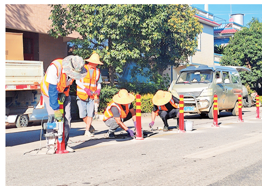
工人在320国道祥云县张营段安装反光防撞隔离桩。(摄于9月10日) 祥云县通过在过境国道、县乡村公路的暗弯和陡坡等危险路段安装防护栏、警示隔离桩等,保障群众出行安全。
