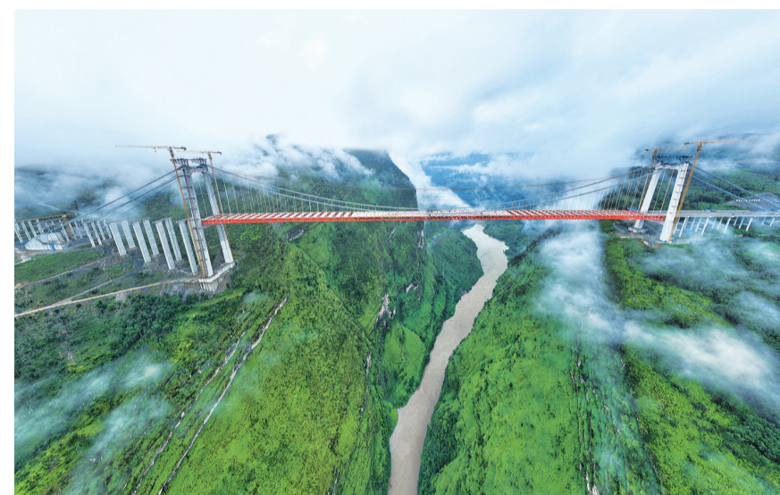
这是9月23日拍摄的天门特大桥(无人机照片)。9月23日,由中铁广州局等单位承建的贵州安(安顺)盘(盘州)高速天门特大桥成功合龙。天门特大桥是安顺至盘州高速公路的重要控制性工程,大桥全长1553米,桥面距离峡谷水面约560米。
