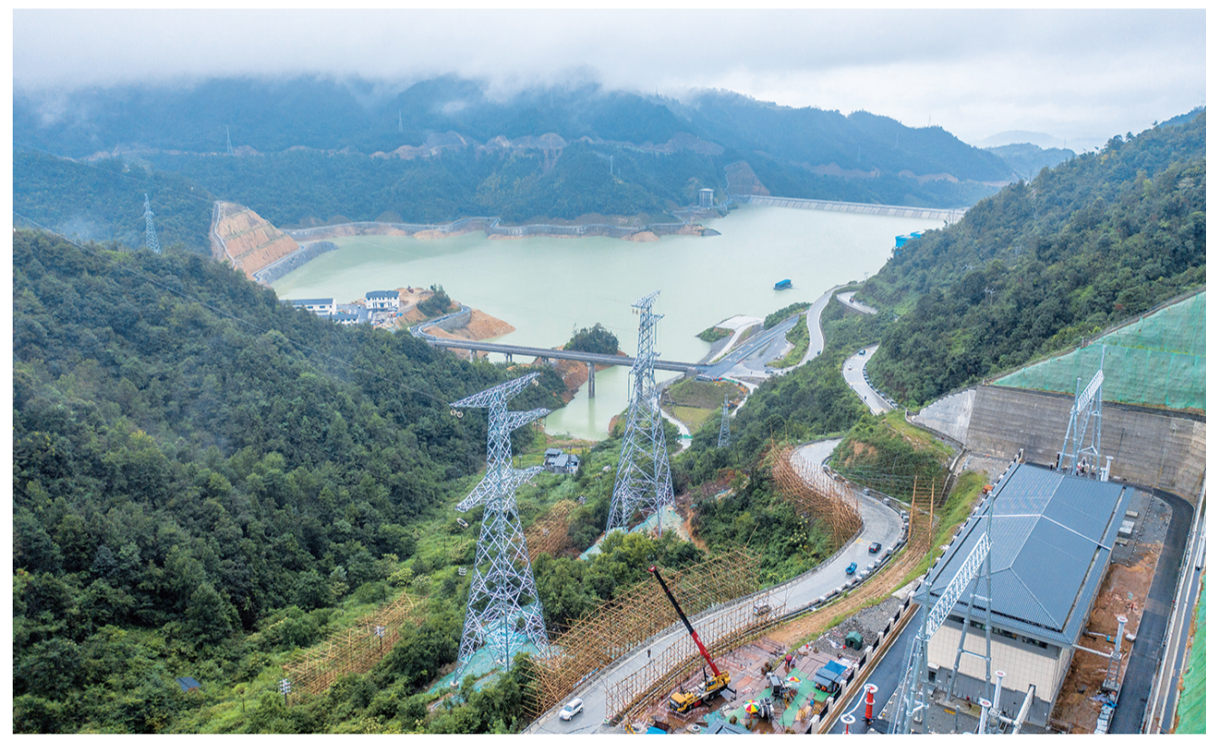
9月23日拍摄的浙江天台抽水蓄能电站的开关站(右)、输电铁塔及下水库(无人机照片)。
