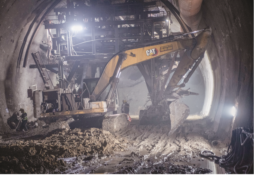
9月27日，工人驾驶工程机械在成渝中线高铁缙云山隧道建设现场施工作业。9月27日，由中铁十二局承建的成渝中线高铁缙云山隧道顺利贯通，为全线按期通车奠定了坚实基础。缙云山隧道位于重庆市沙坪坝区和北碚区，隧道全长5712米，为单洞双线隧道。作为我国“八纵八横”高铁网沿江通道的重要组成部分，成渝中线高铁自重庆枢纽重庆北站起，向西经重庆市渝北区、沙坪坝区、璧山区、铜梁区、大足区，四川省资阳市、成都市，引入成都枢纽成都站，正线全长292公里，设计时速350公里。【新华社记者 唐奕 摄】
