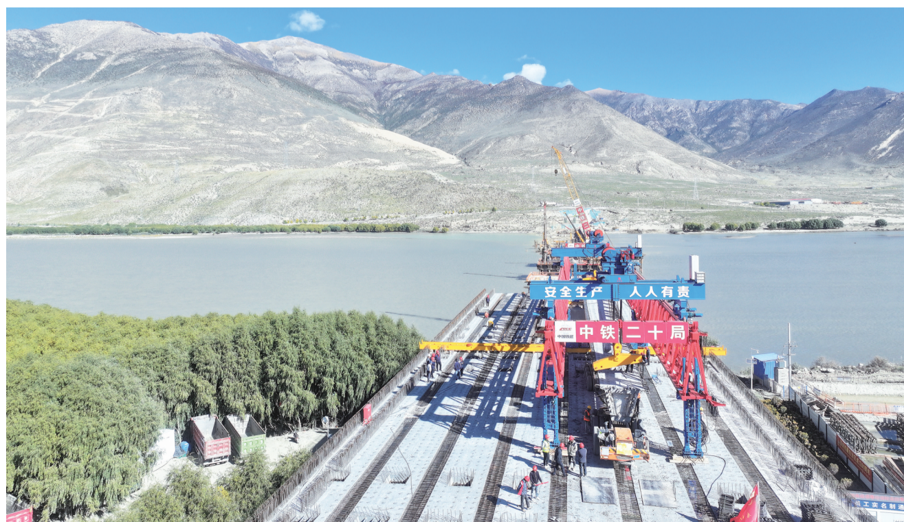
施工人员在架设萨热路跨江大桥的最后一块预制箱梁（无人机照片，10月13日摄）。
