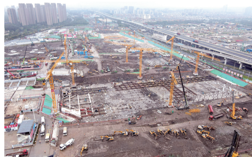
这是10月16日拍摄的正在建设的上海宝山站（无人机照片）。目前，中铁上海工程局承建的上海宝山站建设工程全面加快推进。上海宝山站是国家“八纵八横”高铁网沪渝蓉、沪通铁路的重要枢纽，设计日均铁路旅客到发量14.8万人次。
