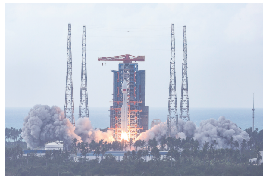
10月16日9时33分，我国在海南商业航天发射场使用长征八号甲运载火箭，成功将卫星互联网低轨12组卫星发射升空，卫星顺利进入预定轨道，发射任务获得圆满成功。
