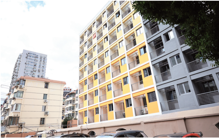
10月23日拍摄的拆除重建后的漕溪三村小区居民楼外景。 2022年7月,经过连续三十年的努力,上海历史性完成成片二级旧里改造的任务,解决了老旧小区居民急难愁盼的住房改造新难题。紧接着,上海打响“两旧一村”攻坚战,拆除重建、抽户改造、户内加装……除传统的动拆迁补偿外,上海因地制宜探索出城市更新的多元解法,让曾经上厕所“拎马桶”、去厨房“抢灶头”的居民们拥抱敞亮的新生活。 【新华社记者 方喆 摄】
