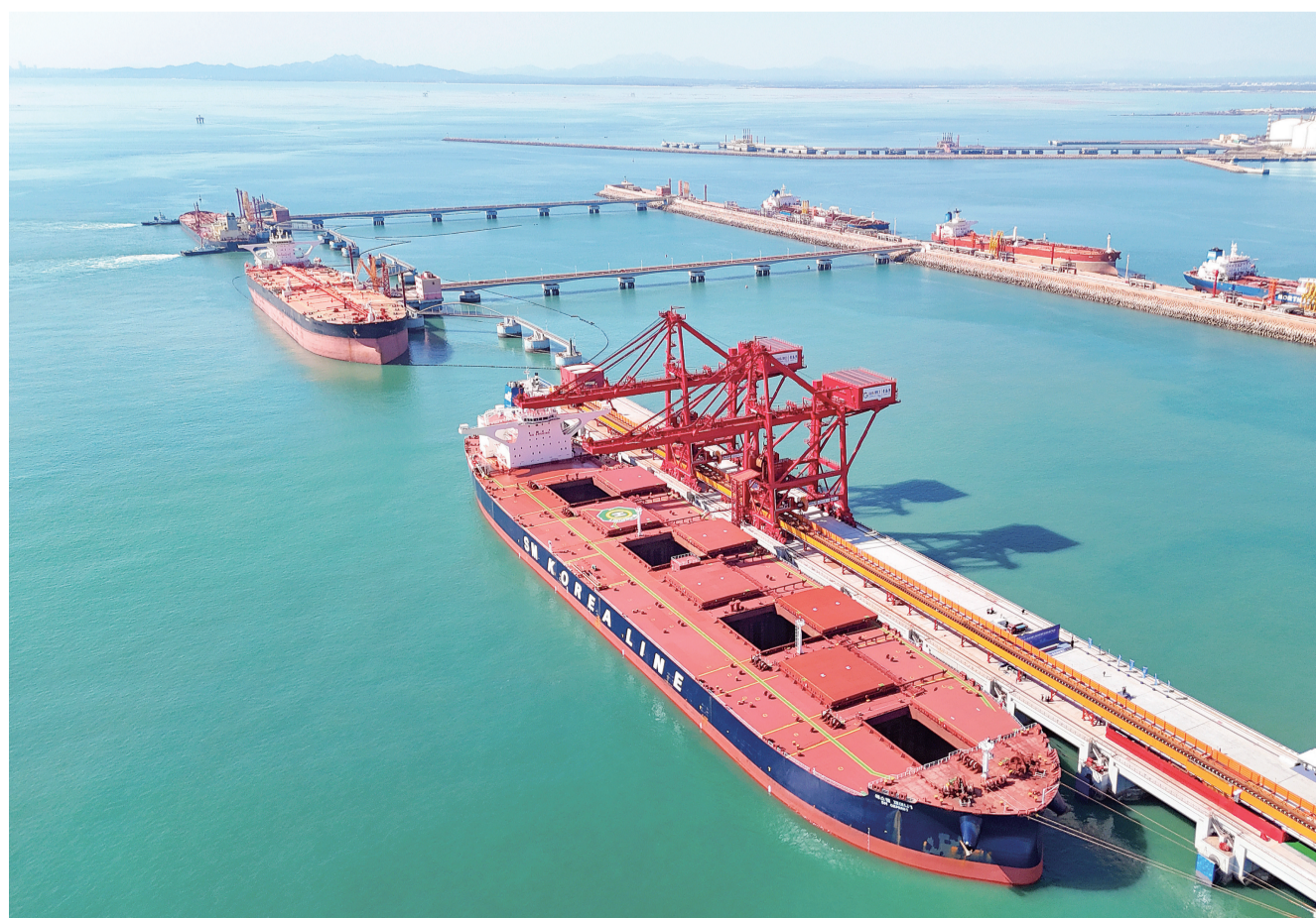
10月27日在山东青岛拍摄的山东港口青岛港第二座40万吨矿石码头(无人机照片)。
