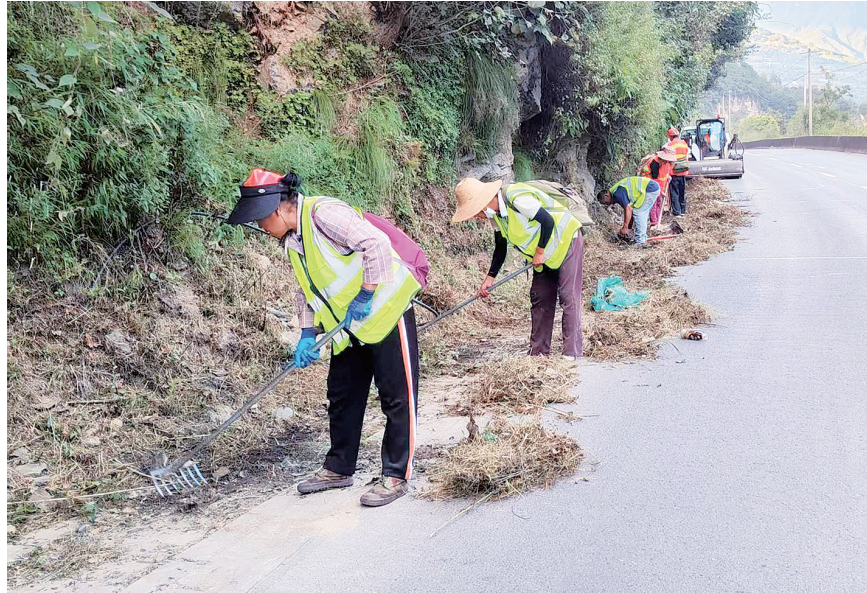
工作人员在G320线清除路肩杂草。(摄于10月15日)
