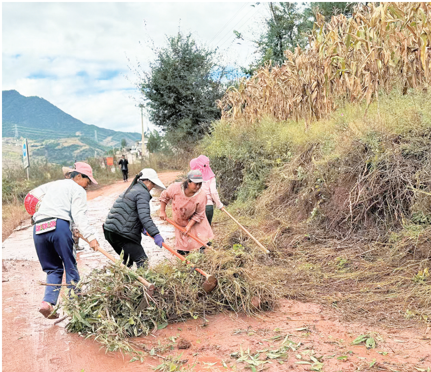
云龙县长新乡丰华村党员和群众正在清理公路。(摄于11月4日) 近期，为全面提升农村公路通行质量与路域环境，长新乡统筹部署、多措并举，组织各村持续开展公路沿线杂草清理和路基整修工作，着力打造畅通、安全、整洁、美观的农村公路环境。
