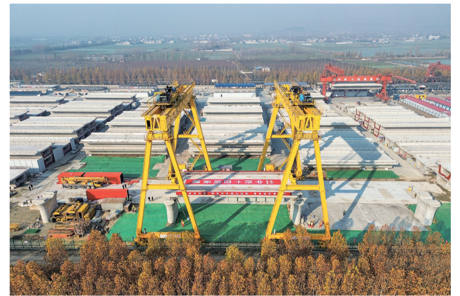
11月21日拍摄的山东临沂濰宿高速铁路九标段跨岚曹高速特大桥首榀箱梁架梁施工现场（无人机照片）。
