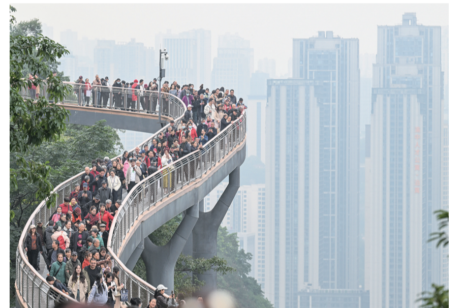
11月24日, 人们在重庆半山崖线栈桥观景。该栈桥全长460米, 宽3米, 最高处距地面28米, 依天然崖壁而建, 将鹅岭公园与佛图关公园连为一体, 独特的观江视野使其成为重庆旅游观光的最新地标。
