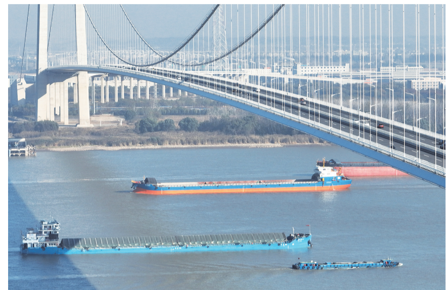
11月26日拍摄的南京新生圩长江大桥（无人机照片）。11月26日，南京新生圩长江大桥建成通车。据悉，南京新生圩长江大桥是南京主城区连接江北新区的重要枢纽，项目全长约13.17公里，主线设计时速80公里，双向六车道。该桥的通车对提升南京长江干线过江能力、完善区域路网体系具有重要意义。 【新华社记者 毛俊 摄】
