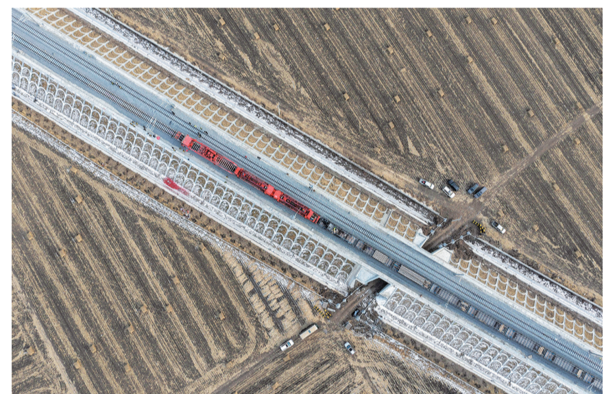
这是11月25日在黑龙江省绥化市庆安县永华村拍摄的哈伊高铁铁轨铺设现场（无人机照片）。11月25日，在黑龙江省绥化市庆安县永华村哈伊高铁铁轨铺设现场，施工方中铁二局的四名工人手持电动扳手，将最后一对钢轨螺栓拧紧，标志着我国“十四五”重点工程哈伊高铁全线铺轨贯通，为后续联调联试奠定基础。 据了解，哈伊高铁于2024年5月28日正式启动铺轨，是我国“八纵八横”高铁网京哈—京港澳通道的重要延伸，也是在建纬度最高、全年温差最大、且首条穿越多年岛状冻土区的高速铁路。 【新华社记者 王松 摄】
