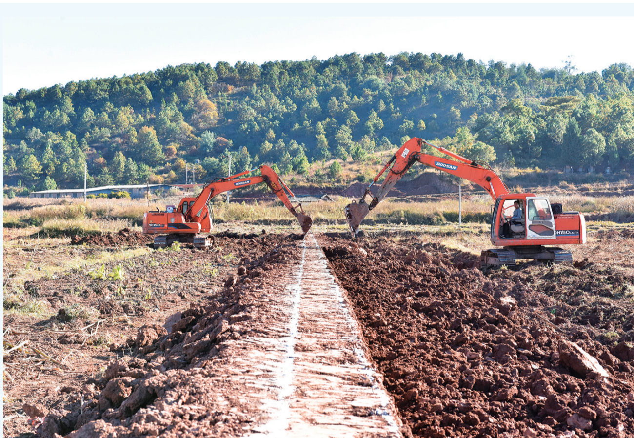
巍山县庙街镇云鹤村委会阿柴村，施工队工人驾驶挖掘机抓紧建设高标准农田。（摄于12月10日）
