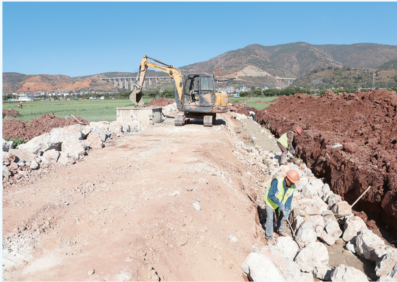
弥渡县寅街镇高营村委会刘家营村进村道路施工现场。(摄于12月7日)
