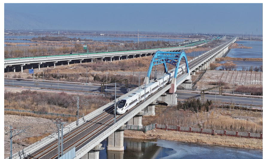
12月23日,包银高铁首发列车D4667次动车组行驶在石嘴山境内(无人机照片)。12月23日,包银高铁包惠段正式建成通车,包银高铁全线贯通运营,“八纵八横”高速铁路网京兰通道全线贯通,完善了西北地区高铁路网,为新时代西部大开发注入新动能。
