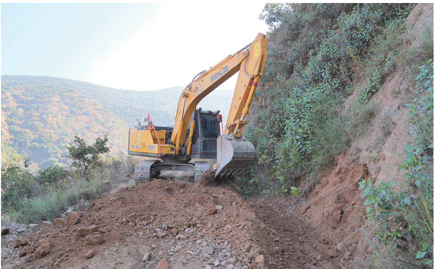
宾川县金牛镇出动挖掘机清理太和社区太平寺森林防火通道。(摄于12月18日) 今年降雨量多,导致防火通道多处塌方,路面坑洼不平以及排水系统不畅等问题,金牛镇投入专项资金,对辖区内近40公里受损的防火通道进行全面整修,保障巡逻车辆和应急队伍通行无阻,为守护绿水青山筑牢安全根基。 [通讯员 沈洪斌 金文祥 摄影报道]
