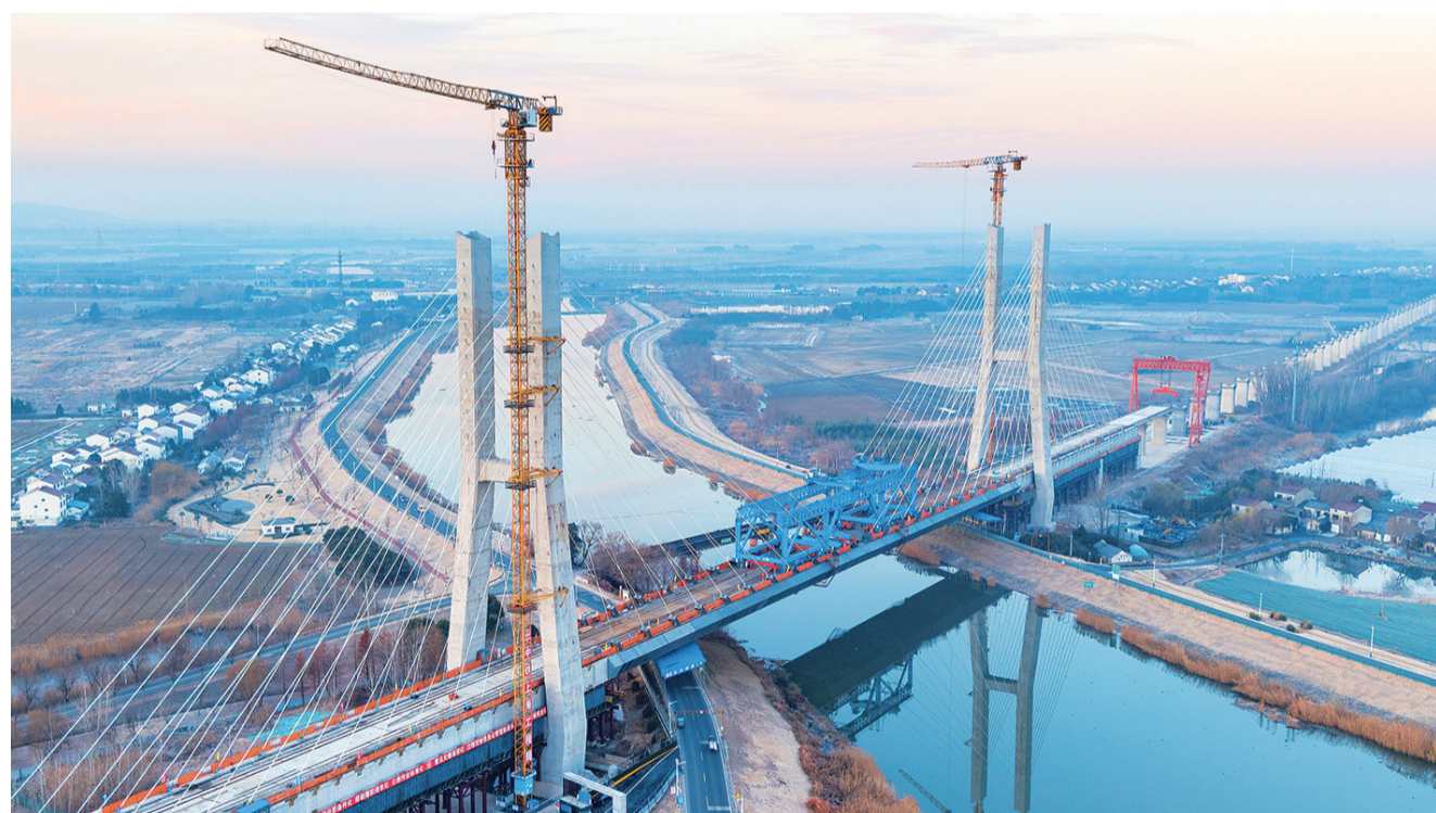
这是1月9日拍摄的沪宁合高铁南京特大桥跨滁河斜拉桥(无人机照片)。
