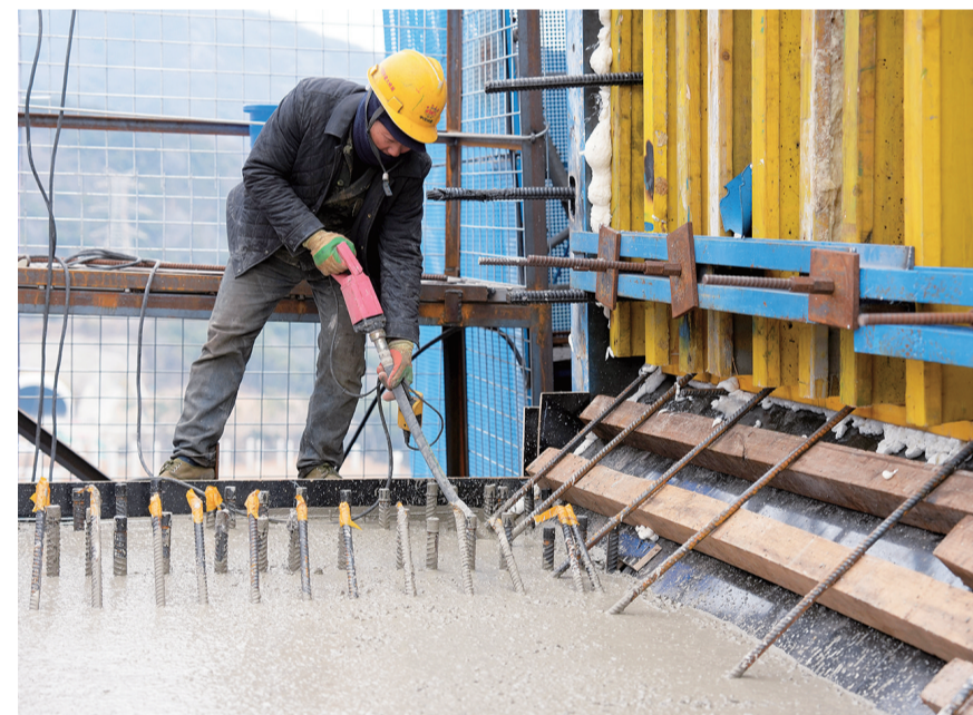
1月25日,建设者在甬舟铁路富翅门公铁两用大桥东主塔上横梁浇筑现场作业。1月25日,由中国铁建大桥局承建的甬舟铁路富翅门公铁两用大桥东主塔上横梁顺利浇筑完成,标志着该主塔主体结构施工取得突破,为后续主塔封顶及全线桥面系施工奠定了基础。富翅门公铁两用大桥连接舟山本岛与富翅岛,是甬舟铁路的控制性工程之一。大桥全长约1726米,主跨达388米,采用双线铁路、6车道高速公路同层布置的形式。【新华社记者 黄宗治 摄】
