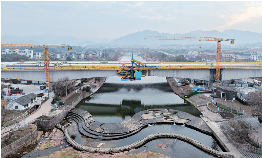
2月3日拍摄的金华铁路枢纽扩容改造项目梅溪特大桥120米连续梁合龙施工现场(无人机照片)。
