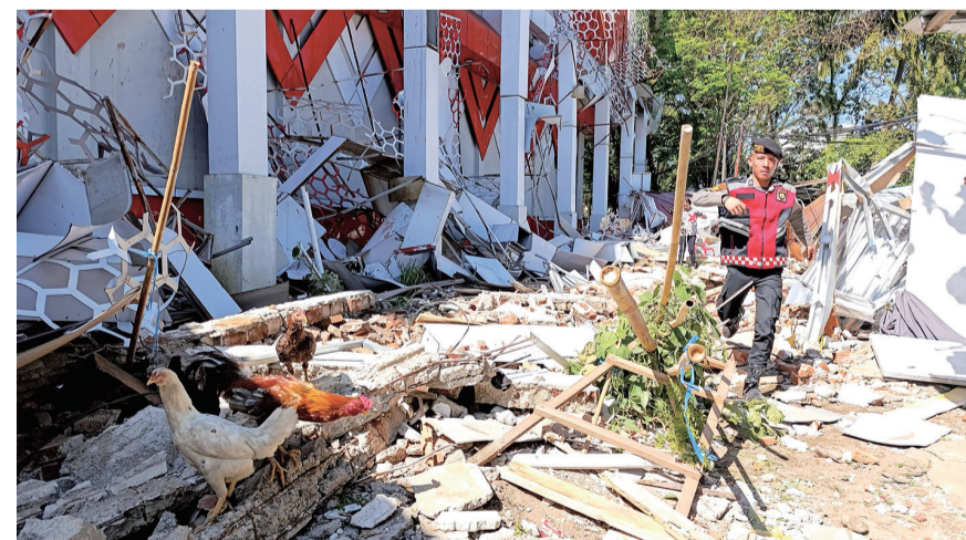
4月2日，在印度尼西亚北苏拉威西省万鸦老，警察在一座受损建筑旁工作。印度尼西亚北马鲁古省附近海域4月2日发生7.6级地震。据搜救部门消息，印尼北苏拉威西省已有1人在当地地震中死亡。 【新华社发（弗兰斯·努格拉哈 摄）】
