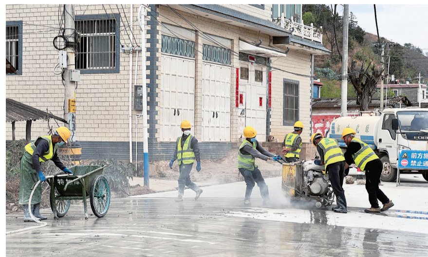
弥渡县弥城镇龙泉社区乡村公路改造现场,工人正在进行路面刻纹作业。(摄于4月8日) 此次改造严格按照三级公路标准施工,通过加铺碎石垫层、浇筑混凝土等工序,全面提升道路承载能力,预计4月25日前实现全线通车。
