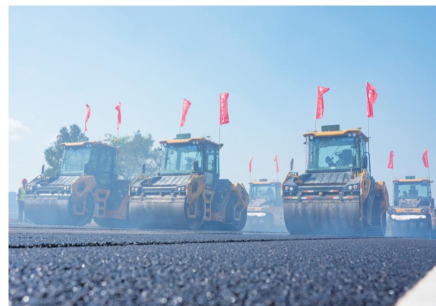
4月18日，在四川省绵阳市境内的G5京昆高速广元至绵阳段扩容工程路面工程施工现场，多台无人压路机进行沥青面层施工作业。
