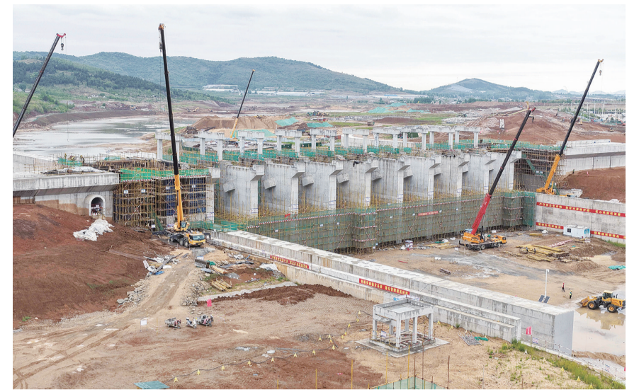
这是4月22日拍摄的蒙河双墩水库重力坝施工现场(无人机照片)。眼下,位于山东省临沂市沂南县的蒙河双墩水库重力坝、泄洪闸、土石坝等主体工程正按汛期节点加速推进。目前,项目累计完成投资超九成,总体形象进度突破82%。蒙河双墩水库是淮河流域综合规划的重大水利工程,设计库容1.4亿立方米。工程建成后,将有效缓解沂河干流和临沂市区的防洪压力,完善山东省水资源配置格局、提升水资源调配能力。【新华社发(王彦冰 摄)】
