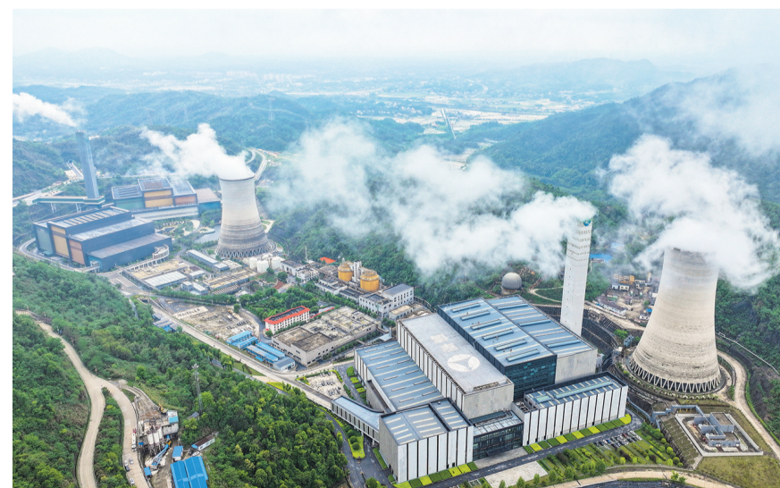
这是4月22日拍摄的军信股份黑麂峰环保园区(无人机照片)。位于湖南省长沙市望城区东北角的黑麂峰下,一辆辆垃圾转运车驶入军信股份黑麂峰环保园区。这个大型综合环保产业园承担着长沙市六区一县生活垃圾及大部分市政污泥的处理。通过构建“固废综合协同处理+绿色能源”模式,园区日生活垃圾(入场垃圾)处理能力达一万吨、污泥一万吨。通过垃圾焚烧发电,园区年产生绿电超17亿度,可满足长沙居民十分之一的生活用电,二氧化碳年减排量超120万吨,为长沙“无废城市”建设与绿色低碳发展注入强劲动能。作为湖南省生态环境科普和教育基地,自2021年以来,在科技活动周、世界环境日及节假日等公众开放日,园区累计接待1800余批、4万余人次参观,通过流程观摩、实景展示等形式,向公众普及垃圾分类和固废资源化利用知识,共护绿色家园。【新华社记者 陈振海 摄】
