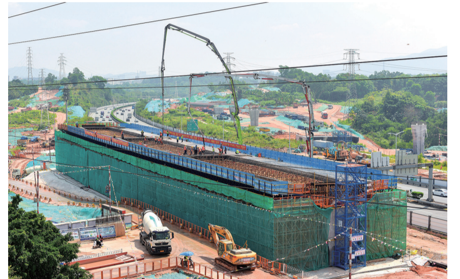
深圳机荷高速改扩建工程九国互通首块现浇梁浇筑现场(4月26日摄)。 4月26日,中铁十一局承建的深圳机场至荷坳段高速公路(机荷高速)改扩建工程浇筑首块现浇梁。机荷高速属于G15沈海高速公路深圳段,作为串联深圳东西的主要通道之一,是粤港澳大湾区东西向的交通中轴线。项目建设对完善国家高速公路网,推进深圳“东拓西联”发挥积极作用。 【新华社记者 毛思倩 摄】
