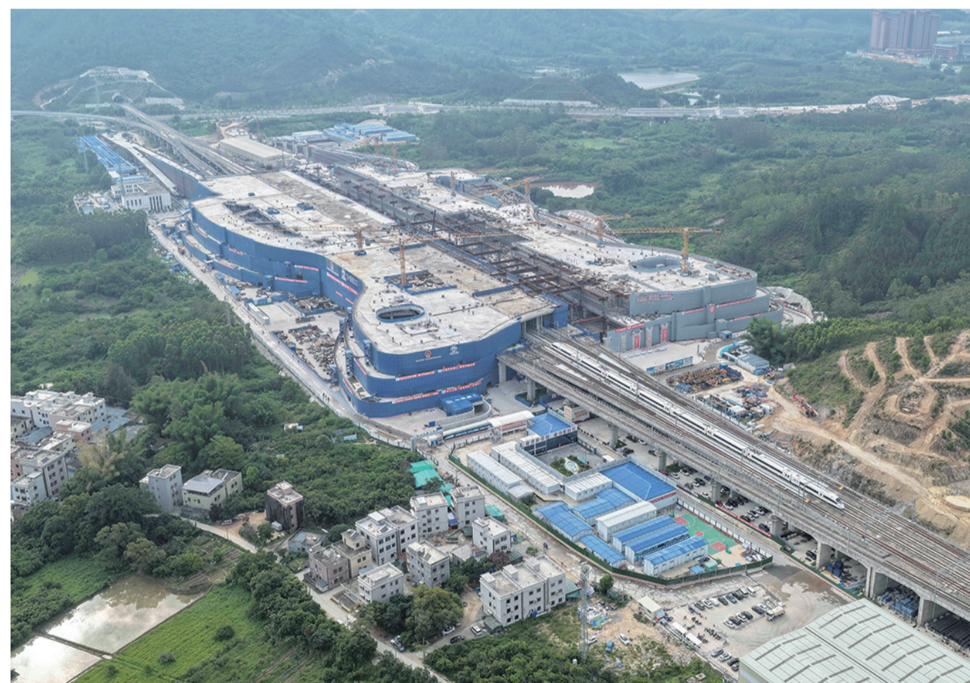
4月28日，列车经过建设中的深汕站（无人机照片）。
