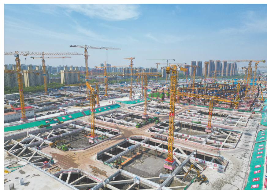
上海宝山站建设项目现场(5月1日报，无人机照片)。
