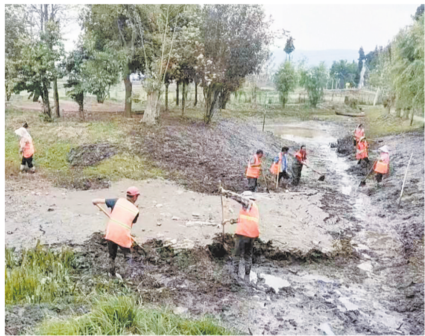
洱源县苴碧湖镇组织开展清除河道淤泥施工。(摄4月29日)
