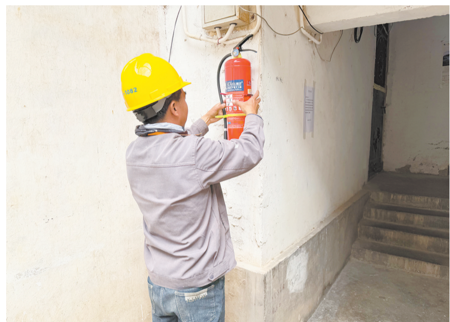
大理市太和街道兴国社区工作人员在老旧小区安装灭火器。(摄于5月7日)
