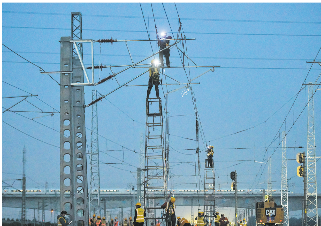
5月11日，中铁十四局工程人员在京九铁路聊城北站上行线改建工程现场施工作业。
