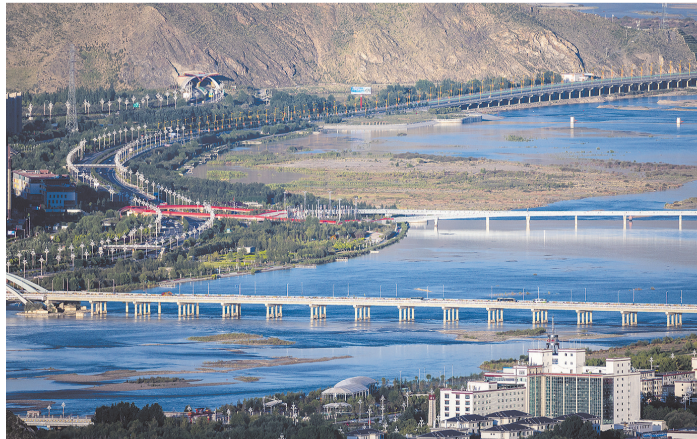
这是横跨在拉萨河上的柳梧大桥(前)和美桥(后)(2025年8月1日摄)。 今年是西藏和平解放75周年。如今，雪域高原天险变通途，纵横延展的“天路”织密出行网络。西藏建成以拉萨为中心，辐射各地市的综合立体交通体系，城乡联通愈发顺畅，切实惠及各族群众，有力赋能区域经济社会高质量发展。 截至2025年底，西藏公路通车总里程达12.52万公里，其中等级公路11万公里，普通国道三级以上公路占比95%。 【新华社记者 姜帆 摄】
