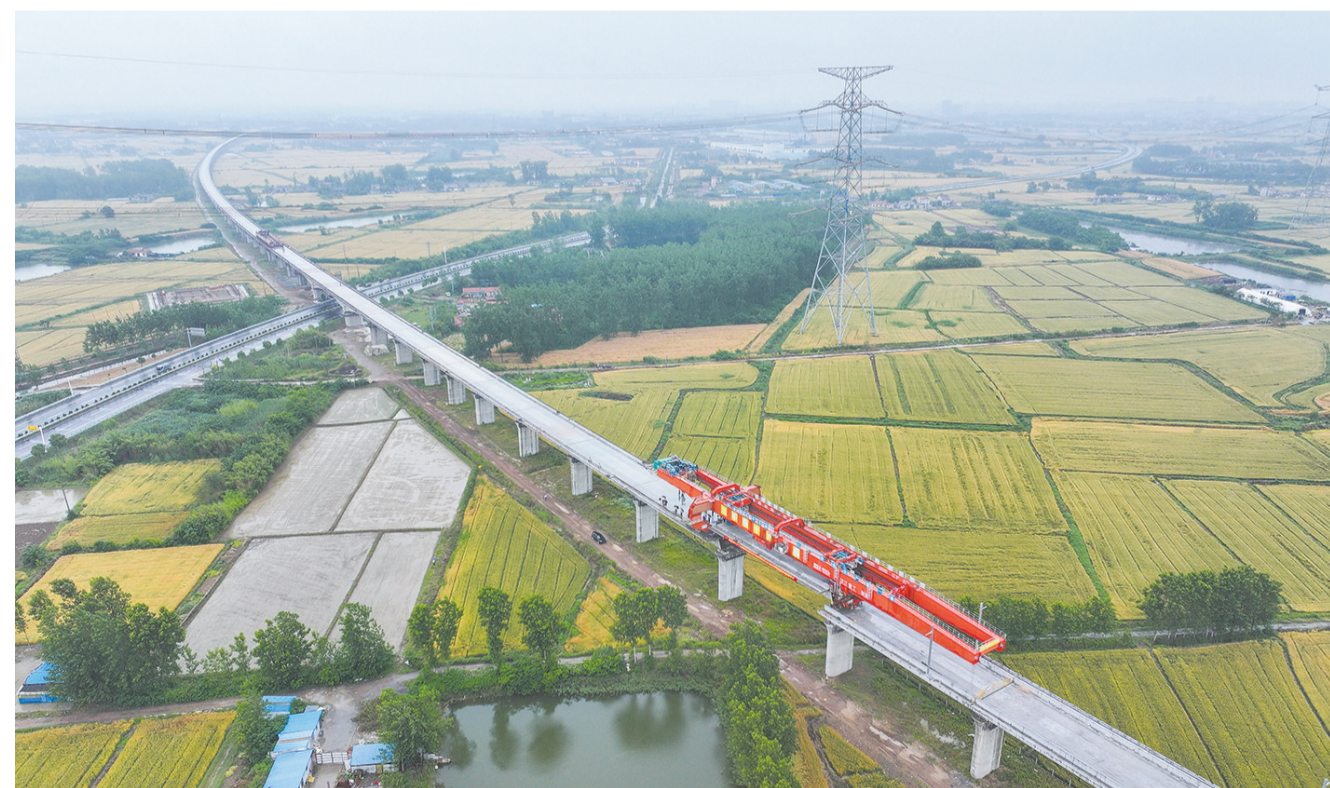
5月24日拍摄的中铁十六局宁淮城际铁路项目最后一榀混凝土箱梁架现场(无人机照片)。
