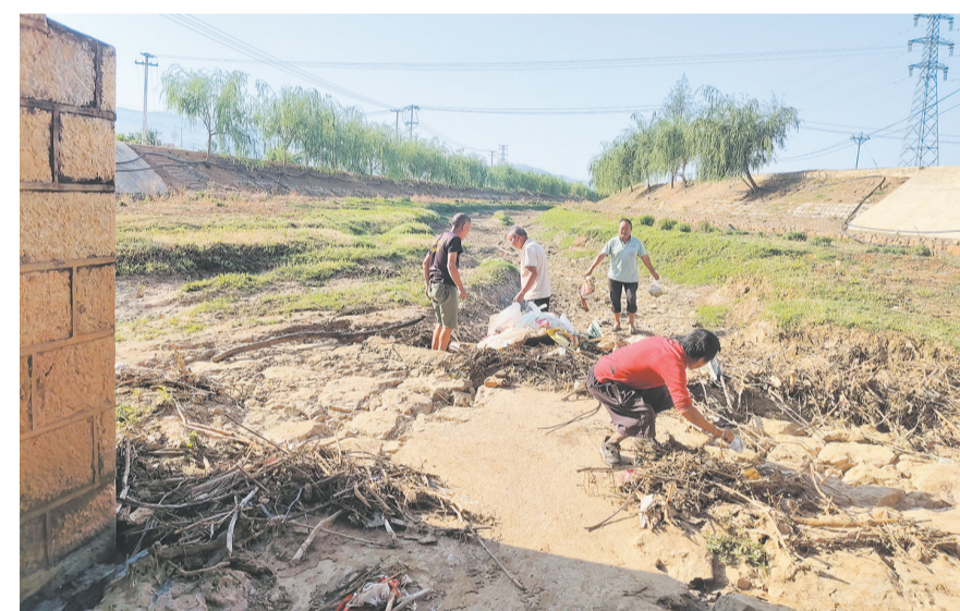
宾川县金牛镇管岗村群众在菜园河开展河道清淤疏浚工作。(摄于5月20日) 为保障汛期河道行洪安全,在汛期来临前,金牛镇组织新坪、管岗、大新、牛井、李相、罗官、仁和、江干等沿河村(社区)开展河道清淤疏浚专项行动。截至目前,已累计完成10.8公里河道清淤疏浚,清理各类杂物27吨。
