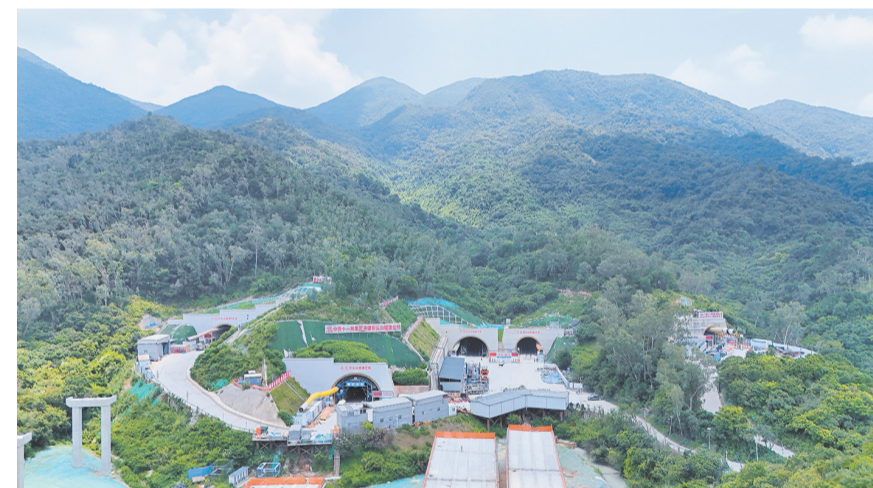
5月29日拍摄的深圳外环回头山隧道群(无人机照片)。5月29日,中铁十一局承建的深圳外环高速三期回头山隧道群B匝道与右线汇合,标志着回头山隧道全面进入大断面施工。回头山隧道群由五条隧道组成,最大施工断面达468平方米。深圳外环高速三期工程穿越回头山自然保护区,连接坪山区和大鹏新区。【新华社记者 毛思倩 摄】
