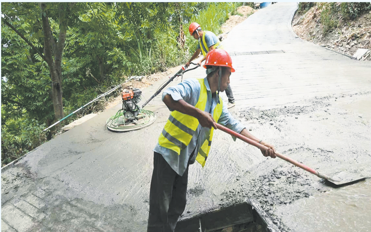
南涧县小湾东镇神村村委会小比密村进村道路硬化施工现场。(摄于5月26日)
