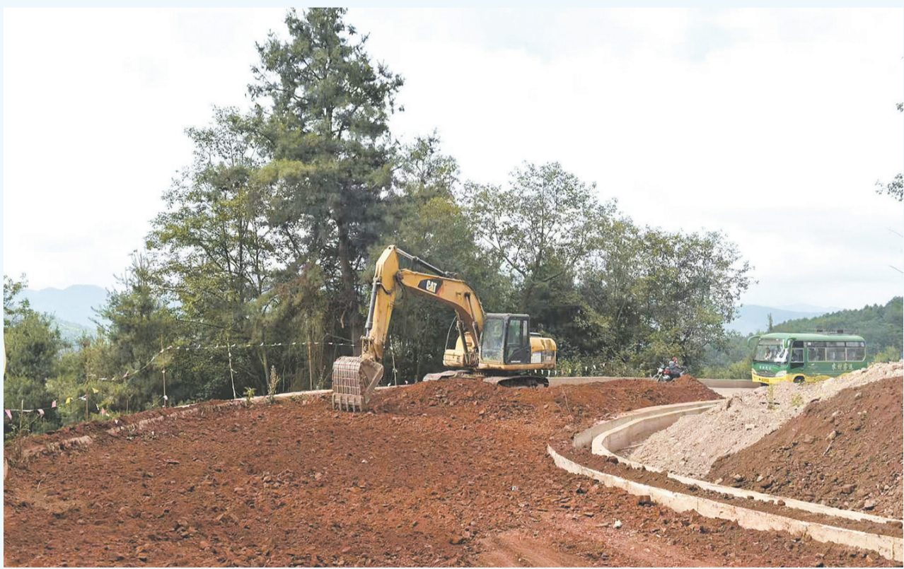
施工队在巍山县青华乡民强村路段实施青华乡通乡三级公路改造工程。(摄于6月8日)
