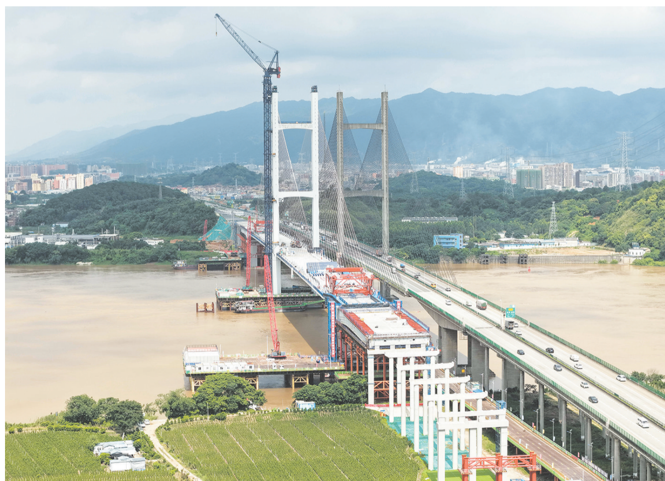
这是6月22日拍摄的广肇高速改扩建工程新建金马大桥(左侧，无人机照片)。
