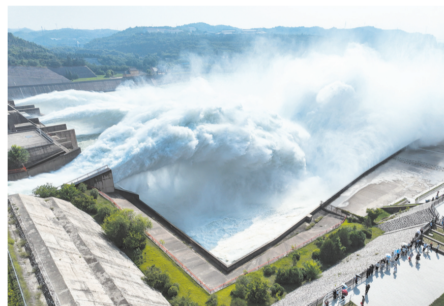
6月27日，游客在黄河小浪底水利枢纽观看“飞瀑”景观（无人机照片）。黄河2026年主汛期前调水调沙自6月22日启动以来，小浪底水利枢纽下泄流量逐渐加大，巨大的水流如飞瀑一般从出水口喷涌而出，蔚为壮观。
