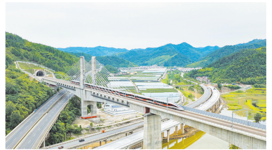
6月30日，列车驶过位于湖北十堰的西十高铁柳家河福银立交大桥(无人机照片)。6月30日上午9时16分，G3966、G3969次列车分别从西安东站和十堰东站对向开出，西安至十堰高速铁路正式开通运营。【新华社发(金伟 摄)】
