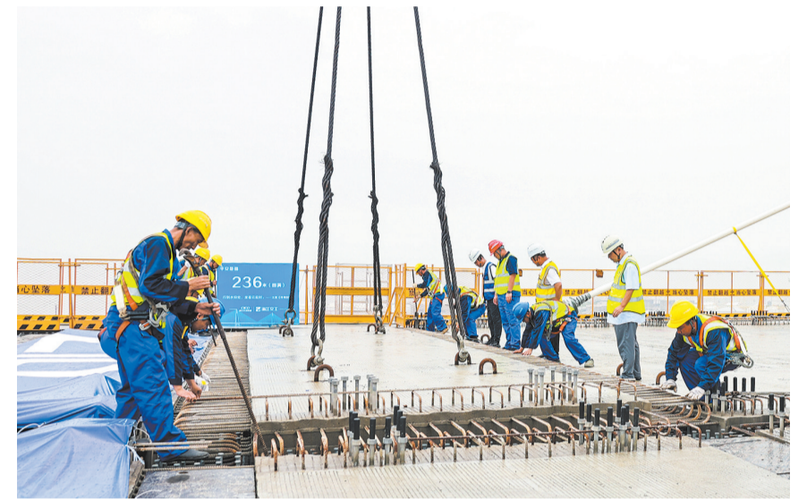
6月30日，工人在浙江省宁波市的杭甬高速复线甬江特大桥合龙处施工现场工作。6月30日，浙江交通集团甬杭甬高速复线三期项目甬江特大桥顺利合龙，为项目建成通车筑牢坚实基础。甬江特大桥位于浙江省宁波市，横跨甬江入海口与镇海港区，全长1730米，是杭甬高速复线三期项目的关键控制性工程。浙江交通集团甬杭甬高速复线三期项目是国家高速公路甬杭甬高速复线的重要组成部分，全长26.15公里，建成后将成为宁波舟山港重要的集疏运通道。【新华社记者 江汉 摄】
