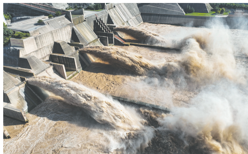
这是7月3日拍摄的黄河小浪底水库排沙出库现场(无人机照片)。从7月2日起，黄河小浪底水库开始排沙，裹挟着泥沙的混浊水流从小浪底大坝出水口排沙洞喷涌而出，场面壮观。小浪底水利枢纽3条排沙洞闸门6月22日开启，黄河2026年主汛期前调水调沙随之启动，水库排沙量预计将超1亿吨。
