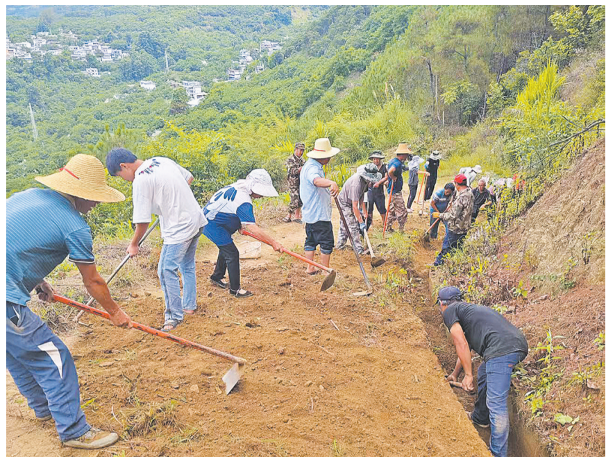
漾濞县苍山西镇光明村党总支组织白林石自然村党员、群众挥锹清沟、疏通排水沟、修复村组路，消除汛期安全隐患，为汛期排洪积极做准备。（摄于6月24日）当日，共组织党员、群众投工投劳20余人，清理后山排水沟渠1.8公里，修复道路2.5公里。 [通讯员 杨新闻 周素亚 摄影报道]
