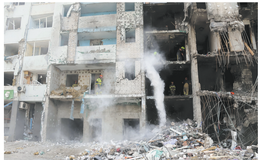
7月6日,在基辅市达尔尼茨基区,救援人员在清理和拆除受损公寓楼结构。据乌克兰官方6日晚发布的消息,5日晚至6日凌晨,俄军对该国首都基辅市和基辅州发动的大规模空袭共造成至少24人死亡,另有106人受伤。【新华社发(彼得·德鲁克 摄)】
