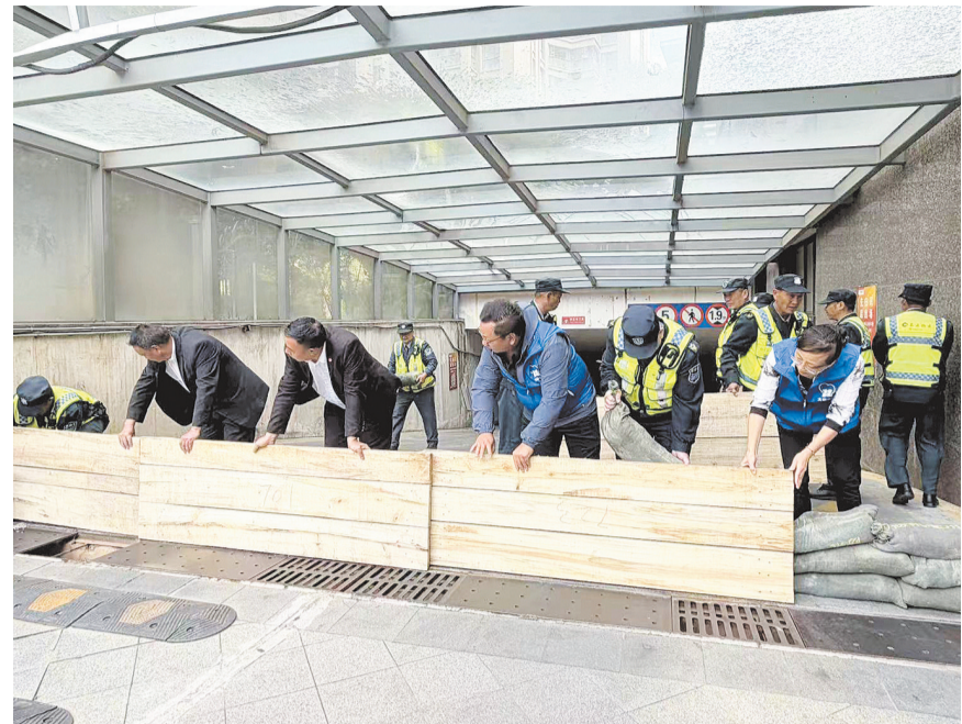
宁和社区防汛应急实战演练现场，参演人员正在演练对地下车库出入口进行封堵。(摄于6月25日)
