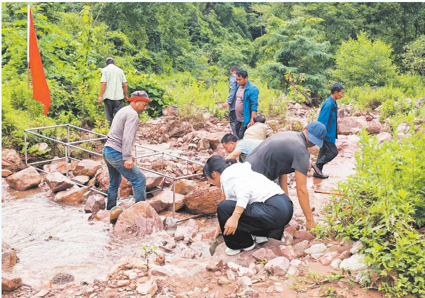
漾濞县瓦厂乡蛇马村党总支组织党员群众开展损毁道路抢修作业。(摄于7月6日)
