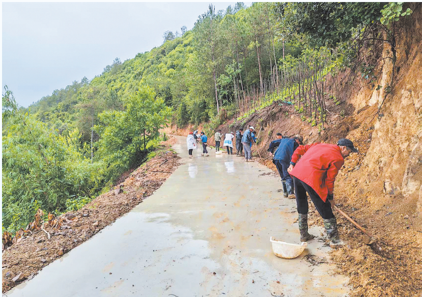
巍山县南诏镇河西村村委会竹麻箐村党员群众正在清理进村道路侧沟塌土。(摄于7月8日)
