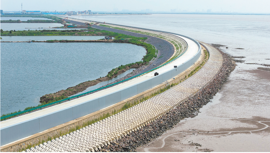
这是7月12日拍摄的天津市滨海新区防潮海堤一期工程(无人机照片)。日前,天津市滨海新区防潮海堤一期工程全线完工并具备防潮能力。据介绍,一期工程长3.4公里,对原有坝体进行全方位升级,新堤堤顶高程达9.2米,比原有海堤提高约2米,以有效应对台风、暴雨与海潮“三碰头”风险。
