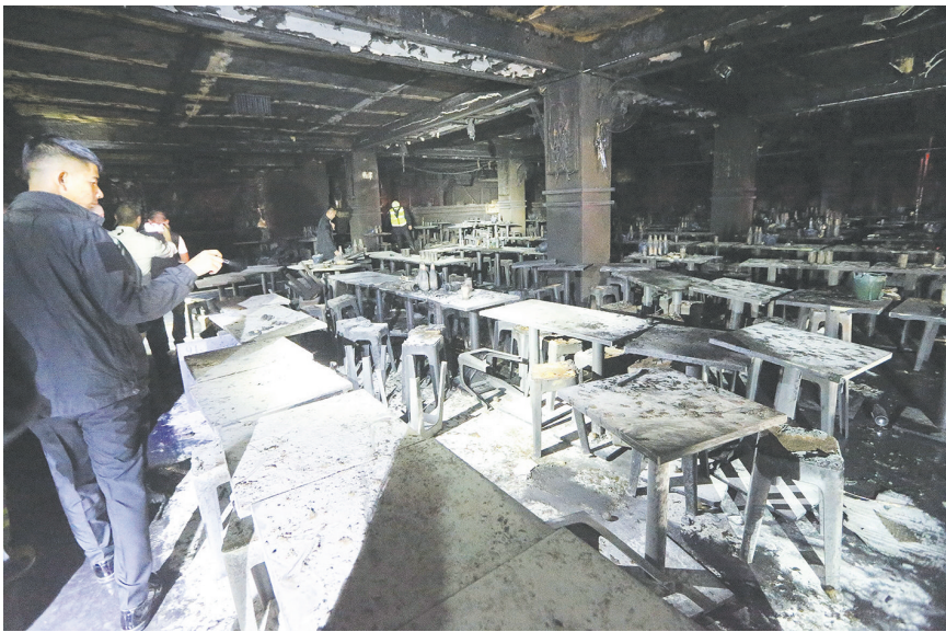
7月13日凌晨，在泰国曼谷，救援人员在火灾现场工作。 据泰国媒体报道，当地时间7月12日23时57分许，泰国首都曼谷乍都乍区拉抛路附近一家啤酒餐厅发生火灾，造成27人死亡、10余人受伤。 【新华社发（拉亨 摄）】
