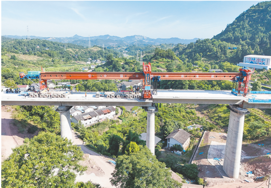
这是7月14日在四川省达州市拍摄的西渝高铁场坝村跨恩广高速公路大桥架梁施工作业现场（无人机照片）。
